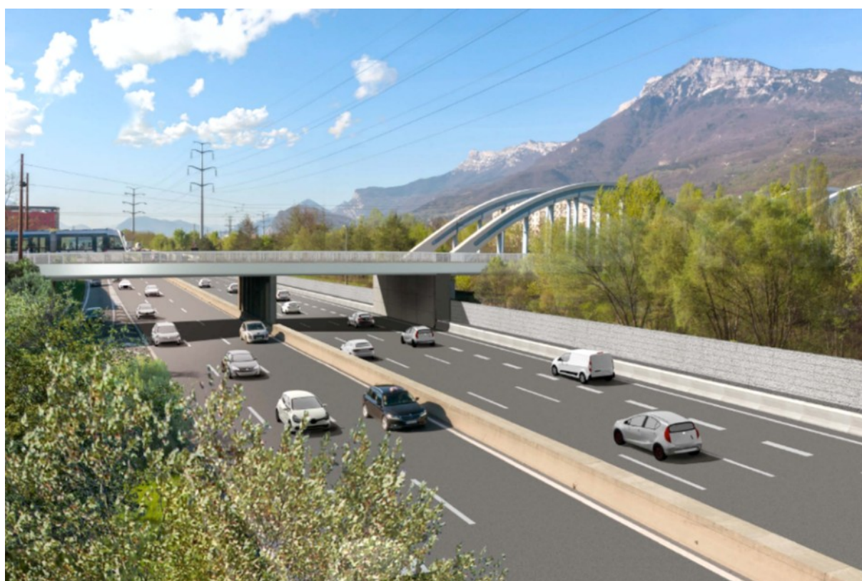
Écran acoustique secteur Vercors avec en arrière-plan le massif - selon projet Alfred Peter
