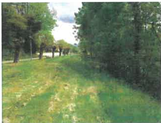
3 : VUE DE LA DIGUE ET DE LA SURFACE A DEBOISER
