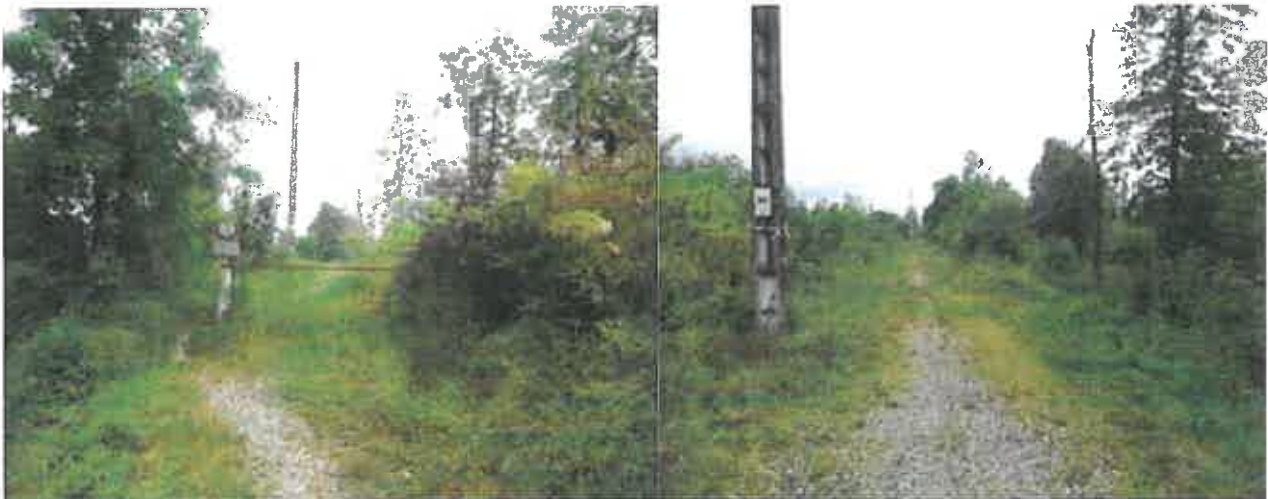
1 : VUE DE L'ACCES AU CHEMIN DE DIGUE ET LE CHEMIN DE DIGUE A AMENAGER
