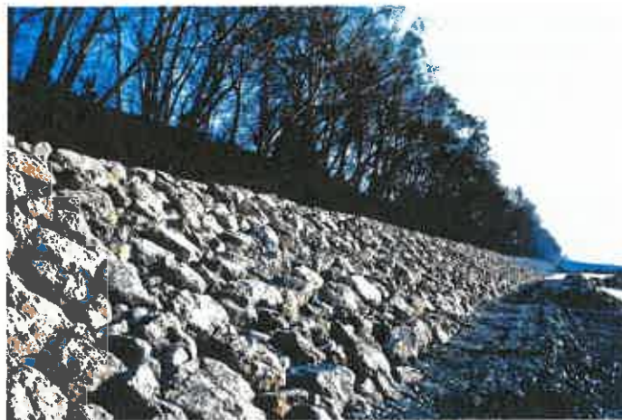
La digue rive gauche en aval du barrage en 1986 avant couverture avec des limons
