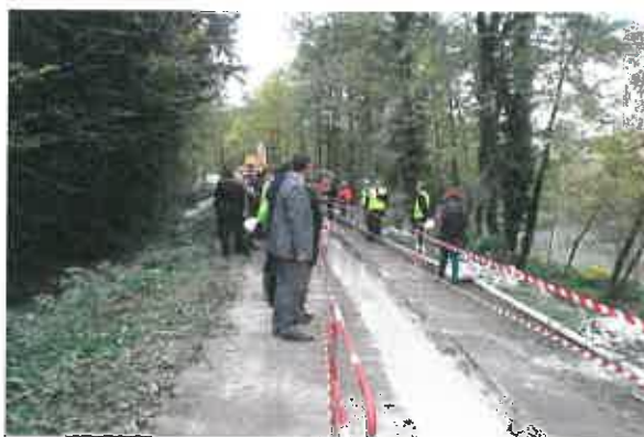
Voile étanche posé par le Symbhi sur 2 km de digue du campus
